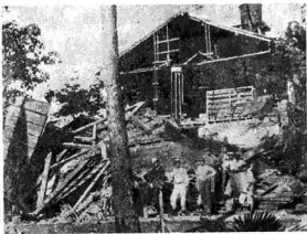
関東大震災で倒壊した教団本部
